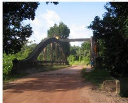
FIGURA 5: Ponte sobre o rio Gramame (2011)
