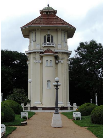
Fotografia 2 – Torre da ETA do DMAE
